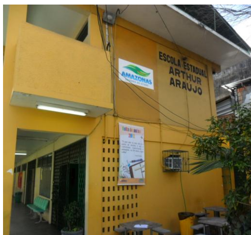
Figura 1: Escola Estadual Arthur Araújo
