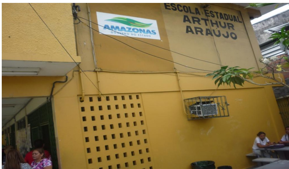
Figura 1 ( Escola Estadual Arthur Araújo)
